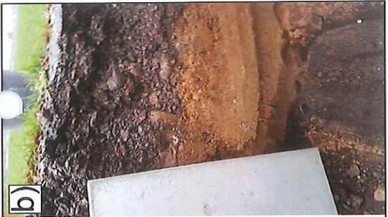
Bild 2: Aufbau der Fahrbahnbefestigung (Maßstab: DIN A4).
