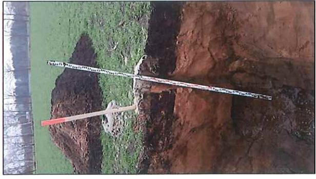
Bild 5: Schurf 22 (SCH 22) mit einer Endteufe von 1,9 m u. GOK
