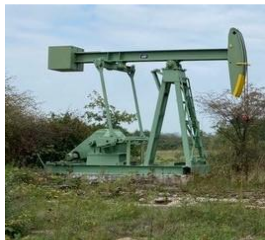
Abb. 22: Pferdekopfpumpen bei Hademstorf
