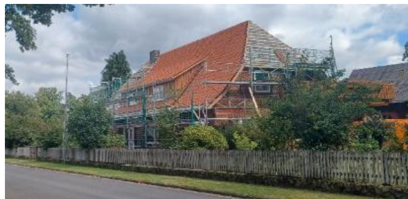
Dacheindeckung im Bau
