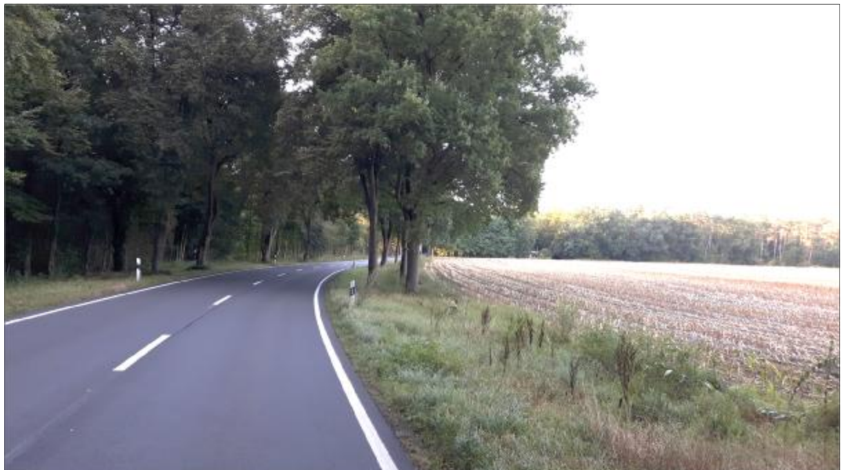
Abbildung 5: Blick in Richtung Norden- L 190, Straßenbäume und Ackerflächen 5
